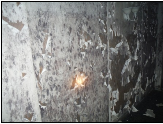
55 : Mold/water damage/peeling paint
